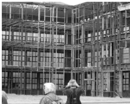
Blick hinter die Fassade der ehemaligen Hanomagfertigungshalle
